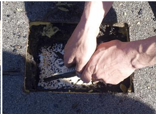
SONDA – PŮVODNÍ VRSTVY
