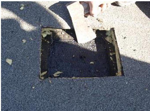
SONDA – VRSTVY PO REKONSTRUKCI
