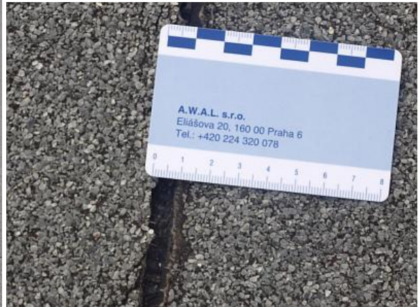
ODTRŽENÍ ASF. MODIF. PÁS OD OPLECHOVÁNÍ ZÁVĚTRNÉ LIŠTY -NEPŘÍPUSTNÉ
