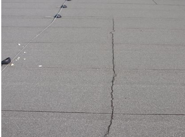
MĚŘENÍ POSUNU DESEK EPS 14MM -NEPŘÍPUSTNÁ ŠÍŘKA
